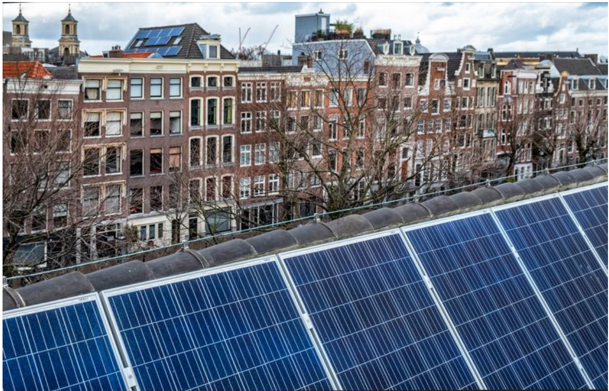
Zonnepanelen op het dak van Museum de Hermitage met uitzicht op Amsterdam. Beeld Raymond Rutting photography
